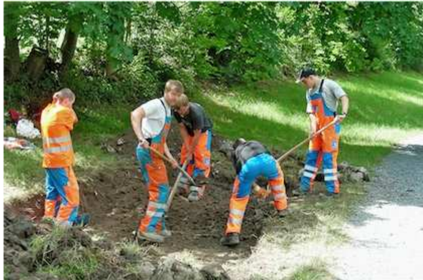
Hier entsteht eine Feuerstelle: Zuerst muss eine Vertiefung für das Koffermaterial ausgehoben werden.
